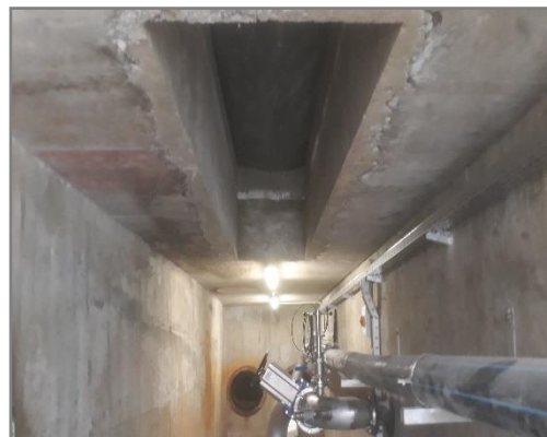
Oczyszczalnia ścieków - Lubartów.
