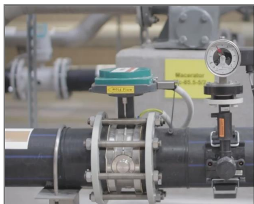
Oczyszczalnia ścieków - Radom.
