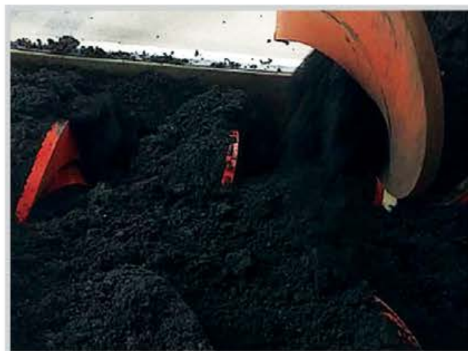
Oczyszczalnia ścieków w Radomiu – osad odwodniony na prasie Bucher 31% s.m.
