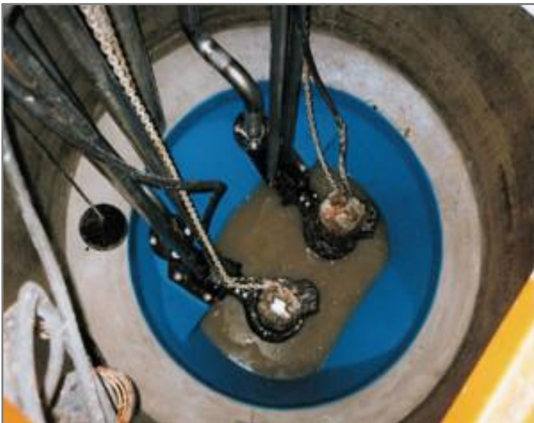
Kompletna pompownia Flygt TOP ze zintegrowanym, zoptymalizowanym układem pompowym
