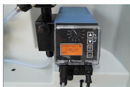
Membranowa pompka dozująca ClO 2 z możliwością nastawy proporcjonalnej do natężenia przepływu wody
