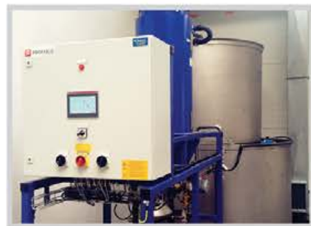
Stacja dozowania flokulantu
