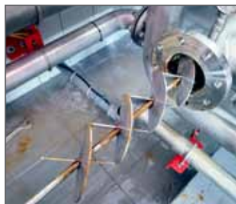
6. włożenie wkładu do miksera
